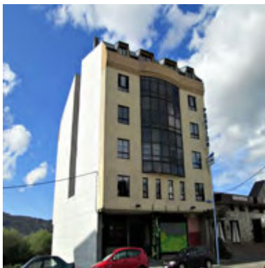
Pensión Teyma en Ponteceso.
